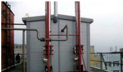
Рисунок 4. Крышная котельная
