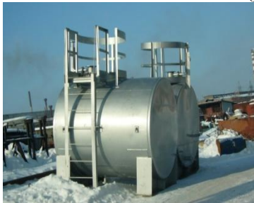
Рисунок 8 – Резервуар для хранения нефтепродуктов
